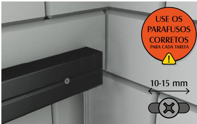
**4** Encoste a primeira régua de ripado por cima do sarrafo. Pré-perfure 1º os orifícios do parafuso da primeira régua de ripado antes de inserir o parafuso, o comprimento do orifício é sugerido para ser 10-15 mm, deixando assim espaço suficiente para a expansão normal do ripado. Certifique-se a 1ª régua de ripado está totalmente nivelada antes de prosseguir para as régua seguintes.
