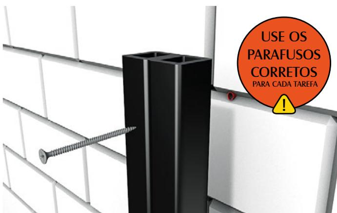
**4** Encaixe a segunda régua de ripado na primeira régua e repita o processo de fixação, certificando-se de que a segunda régua está firmemente encaixada em cada viga de substrutura.
